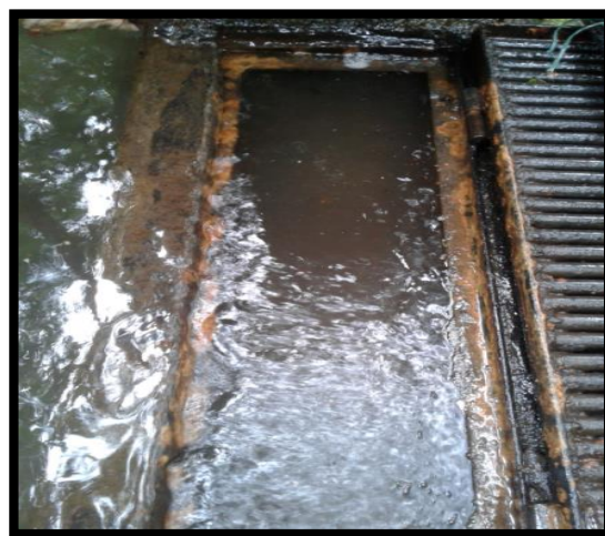
Figura 8 Captación de Acueducto
