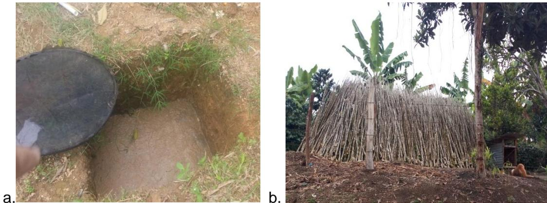
*Figura 7.* Excavación de rebose (ER). a. excavación de rebose, b. arboles de soqueo para introducir a la recamara de rebose.
