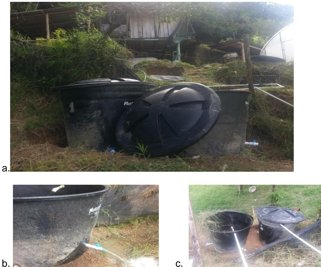
*Figura 10.* Recamaras de bioadsorbentes. a. recamara bioadsorbentes vista frontal, b. recamara de bioadsorbentes salida de agua del sistema, c. recamara de bioadsorbente vista superior.
