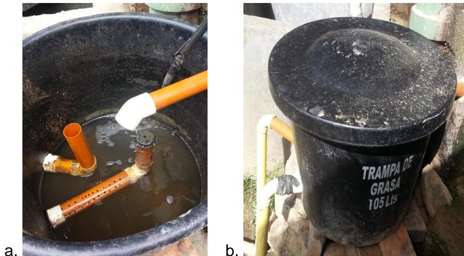
*Figura 6.* Trampa de pulpas (TP). a. trampa de pulpas vista interior, b. trampa de pulpas vista exterior.
