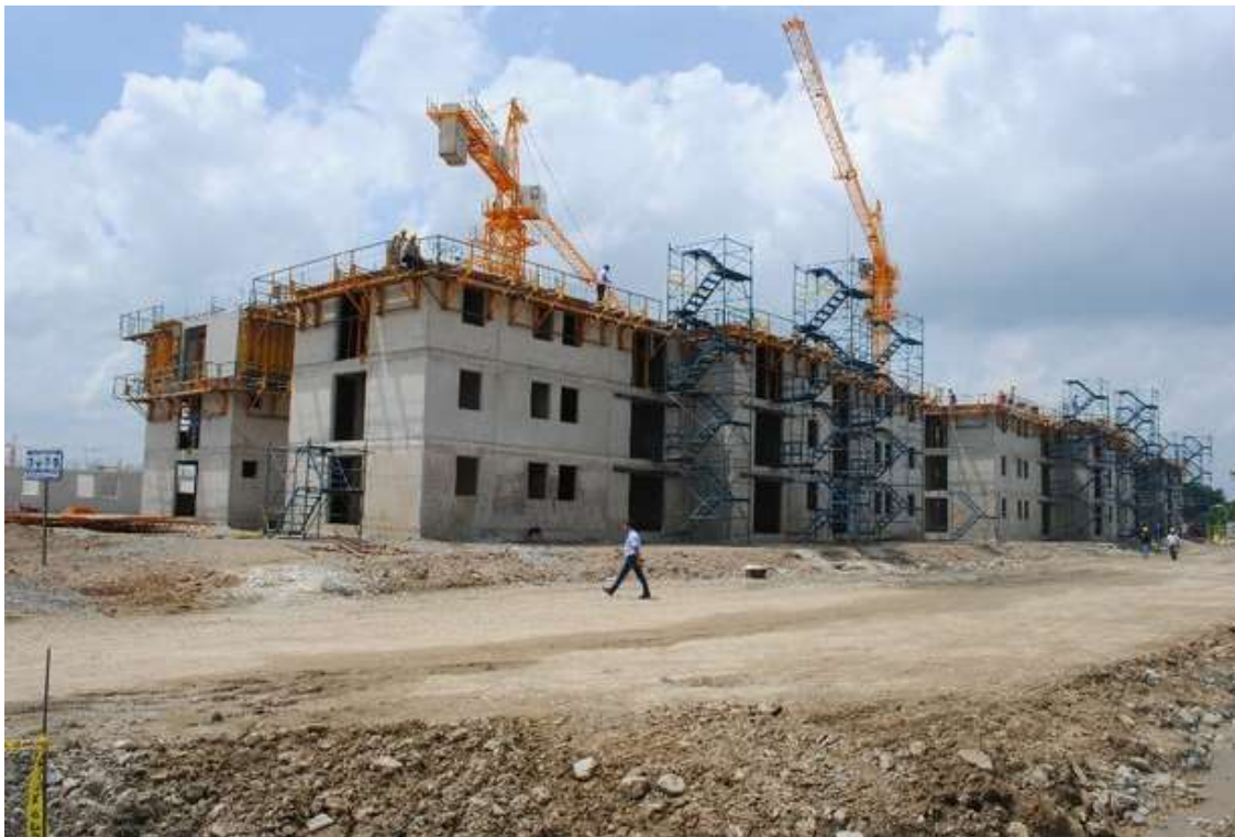
Figura 31 Grúas para izado de materiales en obra.
