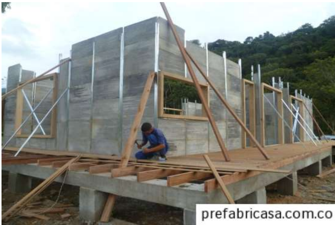
Figura 27 Sistema constructivo prefabricado.
