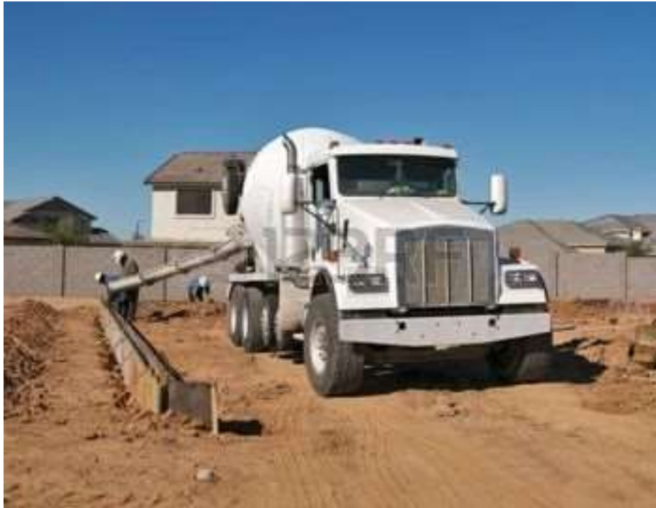
Figura 32 Carros tambores o Míxer para transporte y vaciados de concreto.
