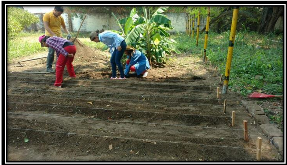
Construcción de la huerta
