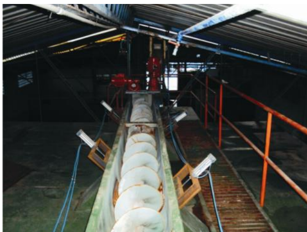
Figura 27. Sistema neumático de los silos de almacenamiento
