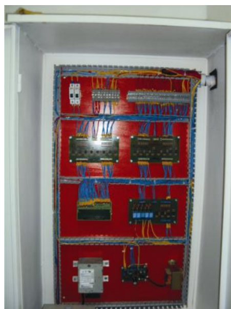
Figura 49. Tablero de control con voltaje de 24 V dc
