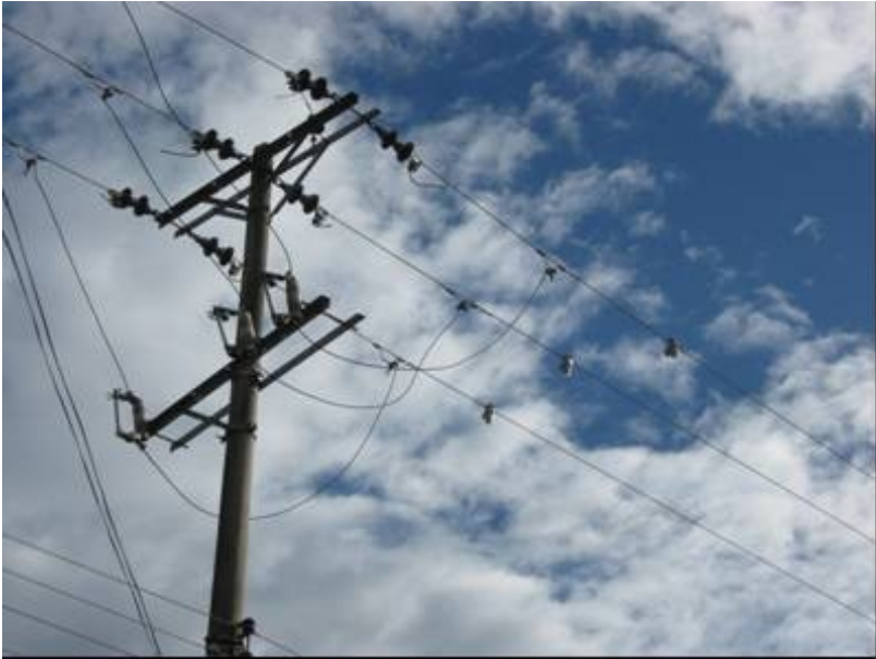
Figura 32. Instalación de Módulo 1
