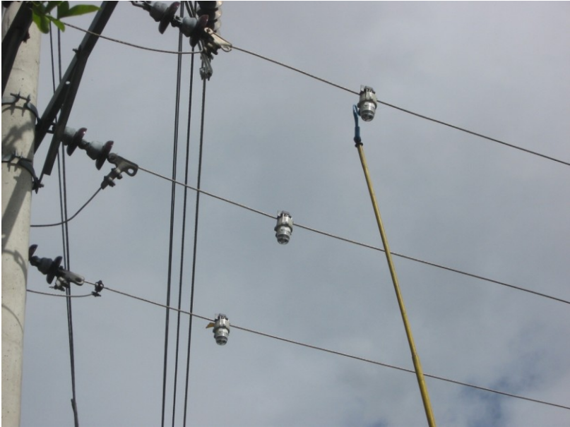
Figura 34. Instalación de Módulo 6
