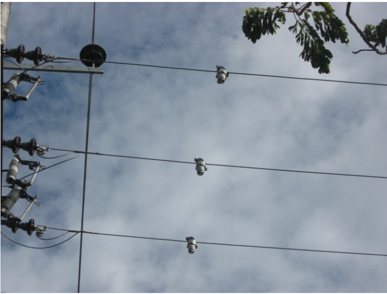
Figura 33. Instalación de Módulo 4
