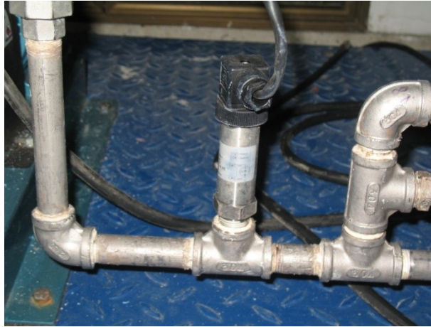
Figura 15. Ubicación del sensor de Presión relativa RITHERM.
