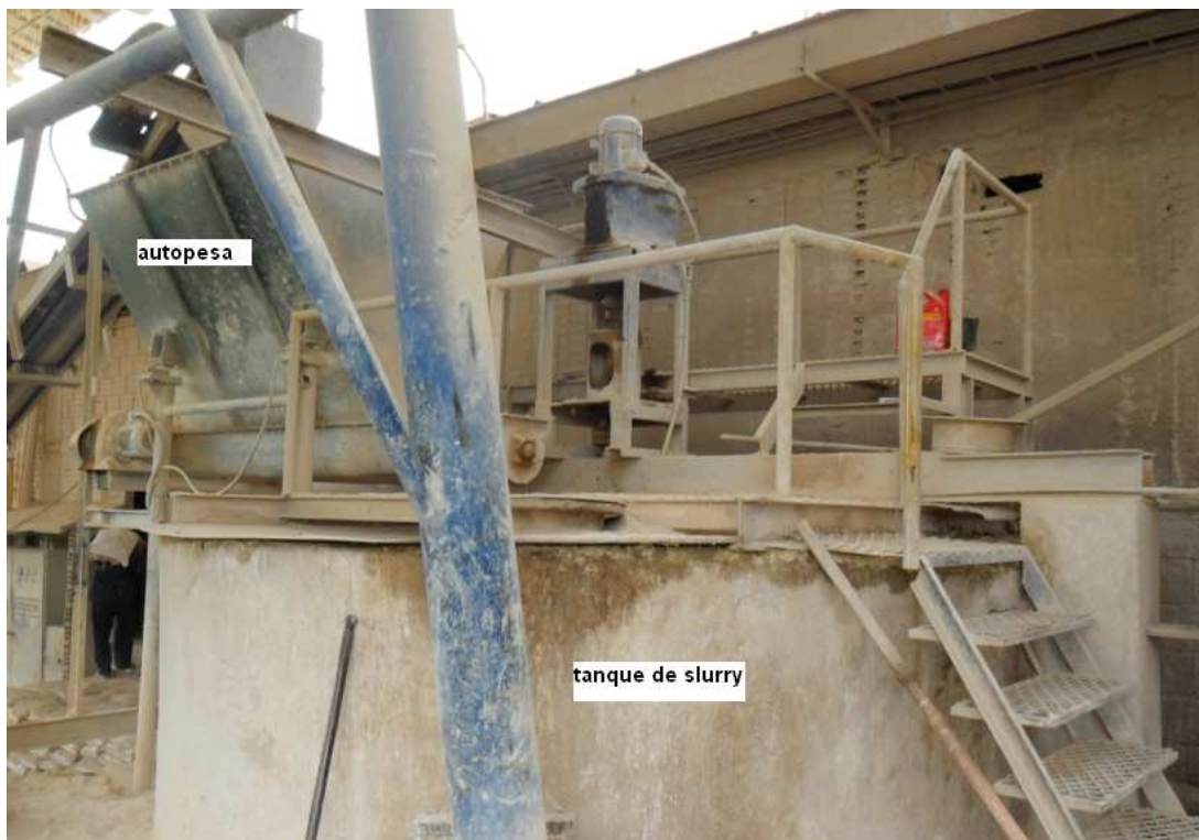
Foto 2 autopesa y descarga hacia tanque de Slurry
