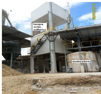
Foto 6 tanque acido sulfúrico y maduradores
