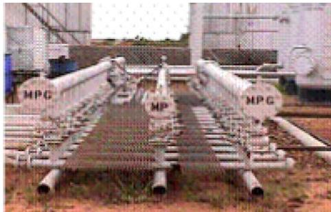
Figura 4. Múltiple de Producción de una estación de flujo.
