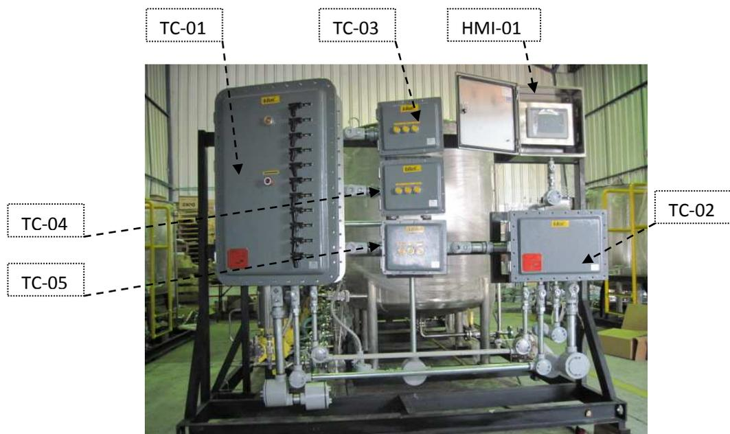
Figura 81. Fotografía de tableros del sistema de dosificación.
