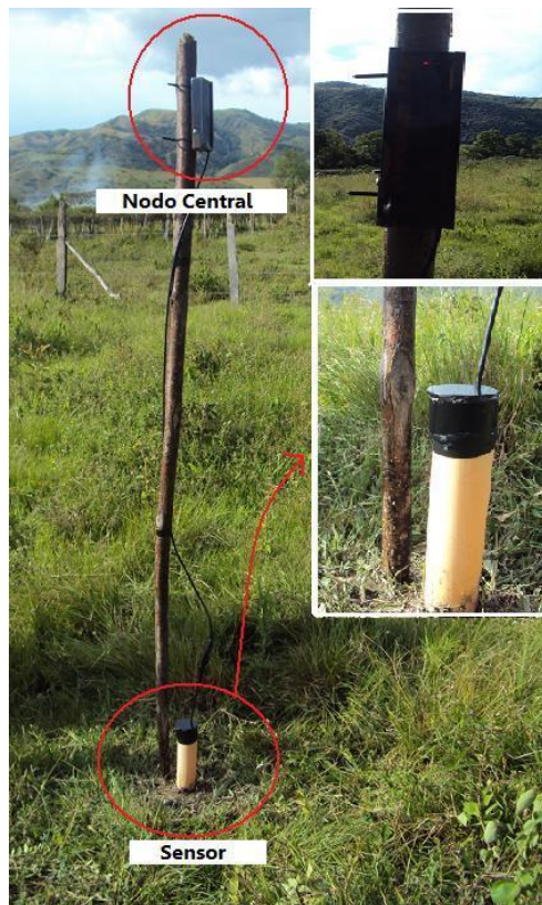
Figura 48. Instalación de sensores y nodos en el pozo
