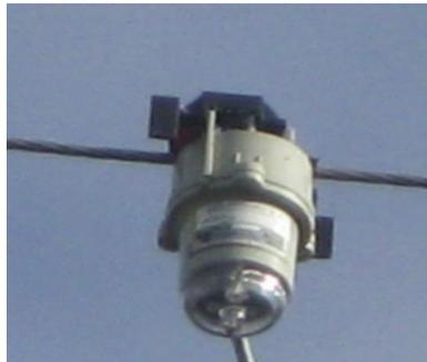
Los indicadores TST-OL se activan al aparecer una falla, y lo hacen de diferentes formas dependiendo de las condiciones del sistema. A esta activación se le llama disparo y se fija mediante la programación previa del dispositivo<sup>4</sup>.
