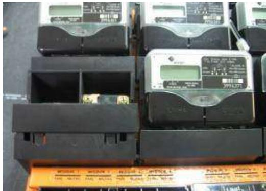
**Figura 1.** Retirar el medidor de la base de conexión.
