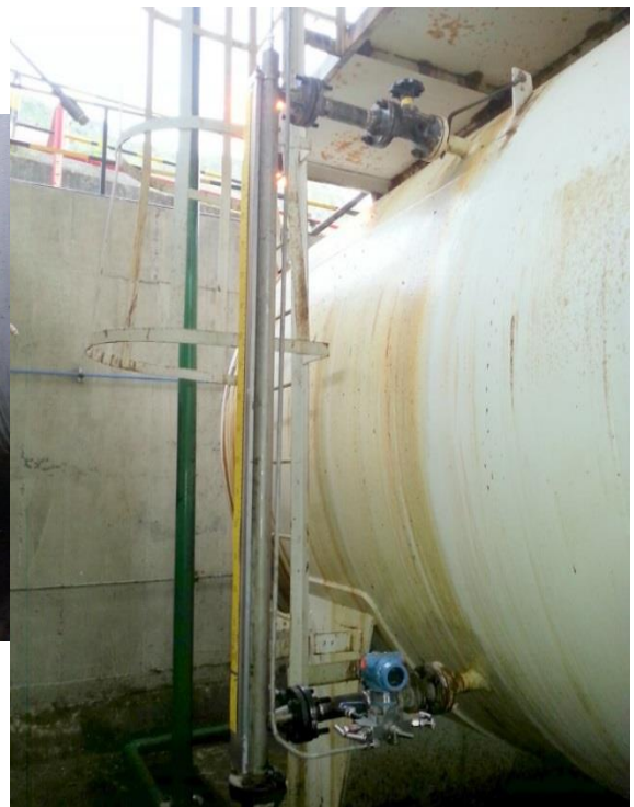
Figura 36. Instalación de transmisor Rosemount 3051CD en Skimmer V-615
