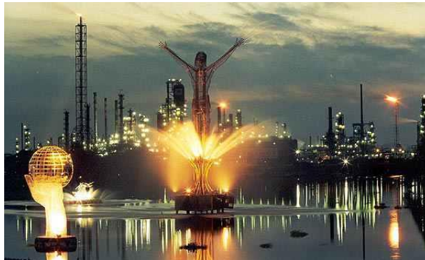
Figura 1. Refinería de Ecopetrol en Barrancabermeja
