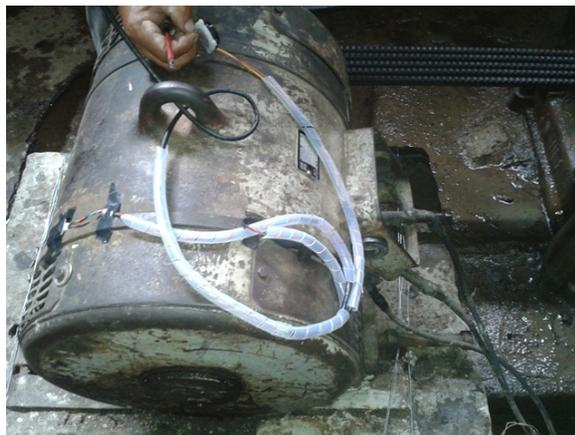
(Sensores conectados al motor de bombeo: temperatura y estado magnético)
