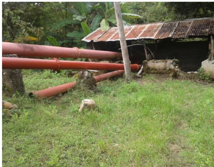
4. Canal de riego (Figura 9). Lleva el agua por medio de la corriente de caudal que se genera desde la bomba, el canal tiene 1 Km aproximadamente de longitud en total hasta el cultivo (Figura 10).
