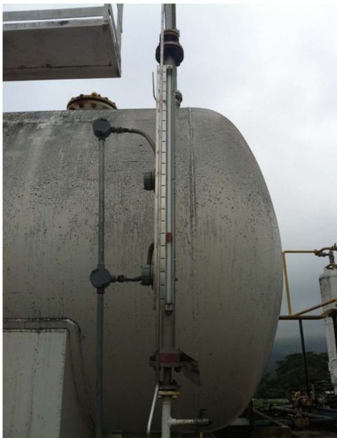
Figura 6. Indicadores de nivel. Sección de separación (derecha) y bolsillo de crudo (izquierda)
