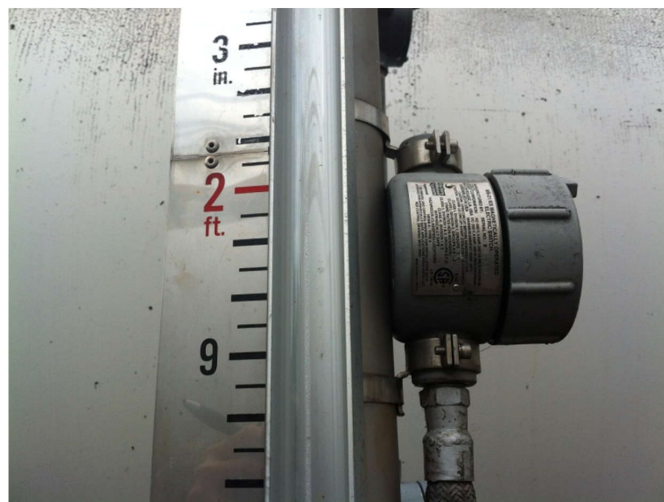
Figura 7. Interruptor de nivel acoplado magnéticamente al LG
