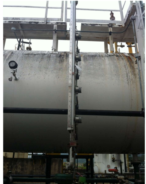
Figura 6. Indicadores de nivel. Sección de separación (derecha) y bolsillo de crudo (izquierda)
