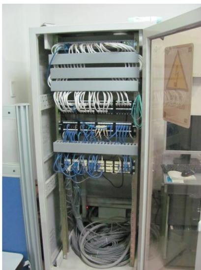
La fotografía muestra el Rack del piso 3 de la Oficina principal de Coonfie, Contiene el switch de conexión de backbone 3COM 4200G 48Puertos, con 40 de ellos en uso.
