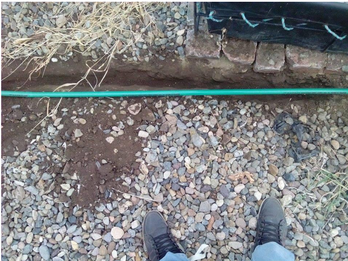
Figura 62. Cercha para el cableado del sensor de humedad.
